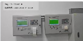
防火门监控器-消防设备电源状态监控器
