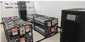
电力系统-检查UPS供电模块
