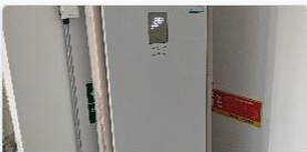
电力系统-高压配电室内落地式空调
