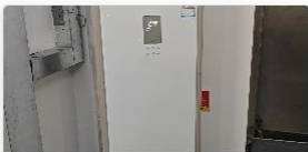
电力系统-低压配电室内落地式空调
