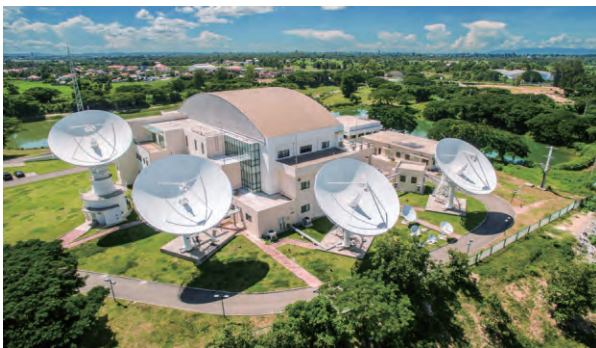
老挝通信卫星地面站
