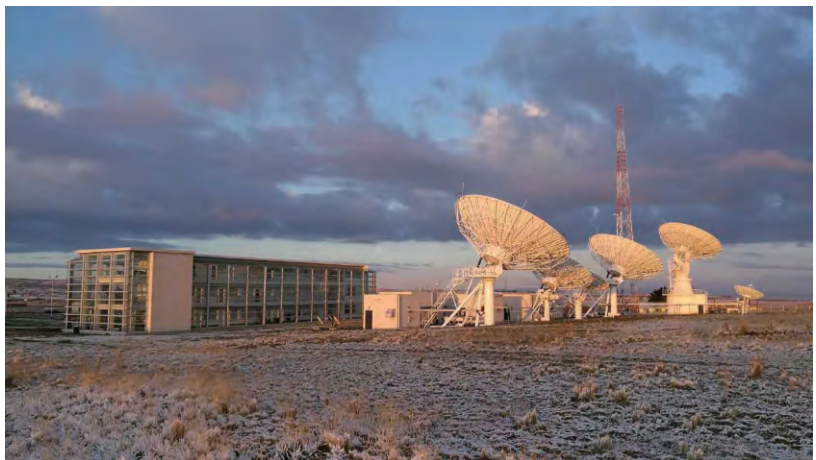
玻利维亚通信卫星电信港
