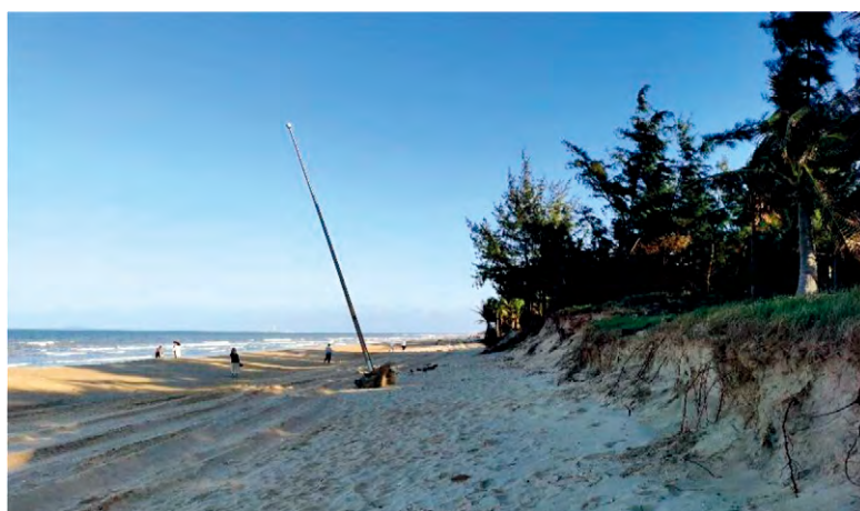
图 39 海口东海岸岸段海岸侵蚀 拍摄时间 20211025；坐标 20.06°N, 110.41°E
